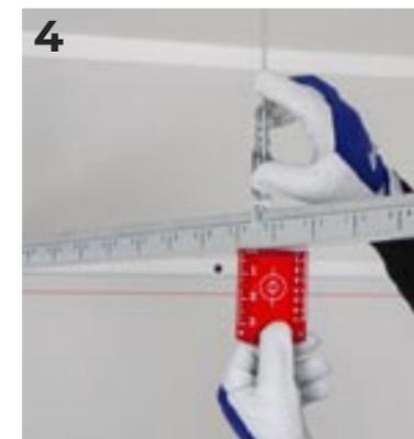
Terminato il fissaggio al solaio di tutti i pendini, questi vanno collegati alla struttura tramite i ganci a molla: premendo la molla il gancio può scorrere lungo il pendino (1), tenendolo sbieco rispetto al profilo sottostante e premendolo su di esso (sempre agendo sulla molla) si divaricano le due ganasce (2) che permettono di incastrarlo sul bordo del profilo, poi lo si ruota in posizione ortogonale al profilo per ottenere il bloccaggio (3).
